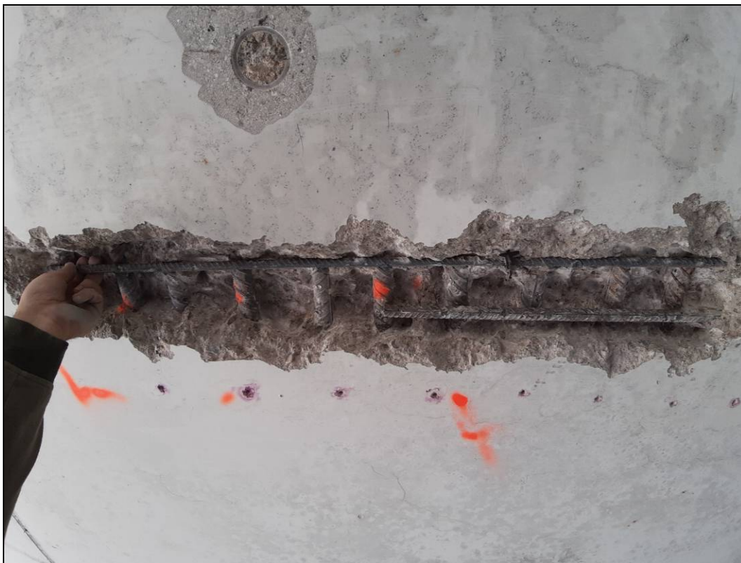
Obr. č. 12 – sonda do levé části nosné konstrukce pro ověření výztuže
