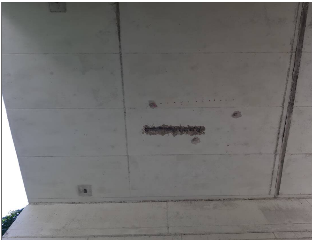
Obr. č. 10 - pohled na spodní líc pravé části nosné konstrukce - spára mezi SS a NK je suchá, rovněž DS mezi levou a pravou částí NK (viditelná sonda do konstrukce)
