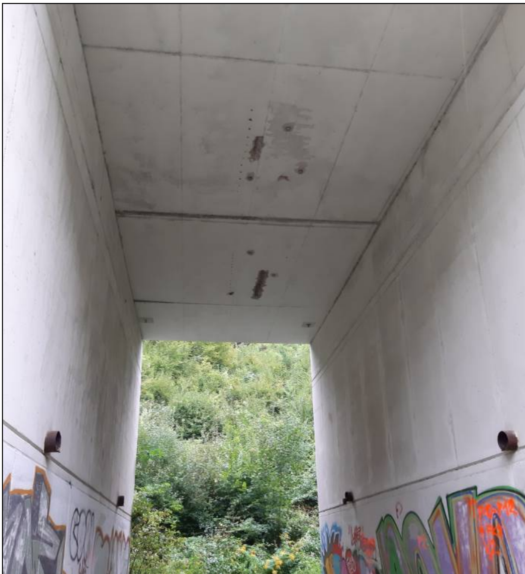
Obr. č. 9 - pohled na spodní líc nosné konstrukce (viditelná dilatační spára, rozdělující NK objektu podélně na levou a pravou část)
