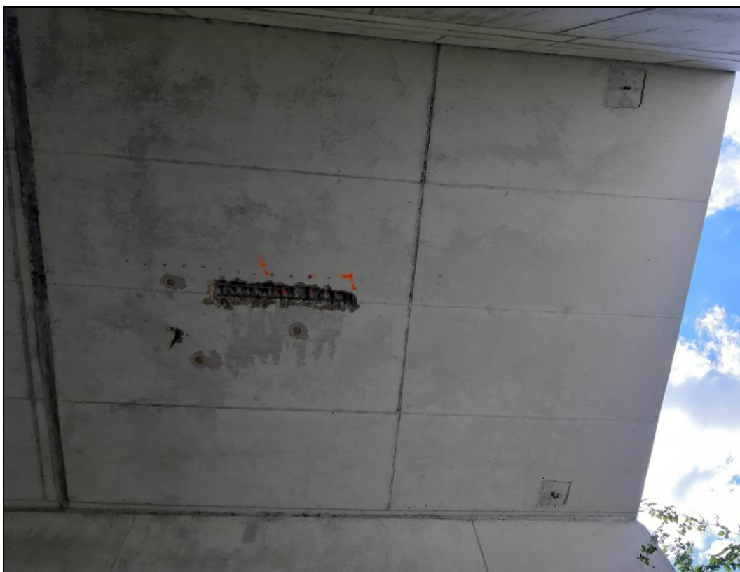
Obr. č. 11 - pohled na spodní líc levé části nosné konstrukce - spára mezi SS a NK je suchá, rovněž DS mezi levou a pravou částí NK (viditelná sonda do konstrukce)
