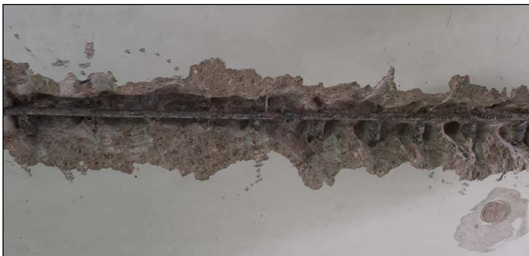
Obr. č. 13 – sonda do pravé části nosné konstrukce pro ověření výztuže
